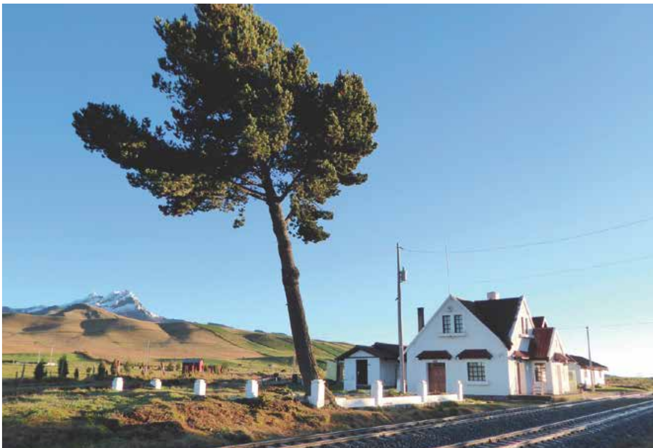
Estación del tren en Urbina.
