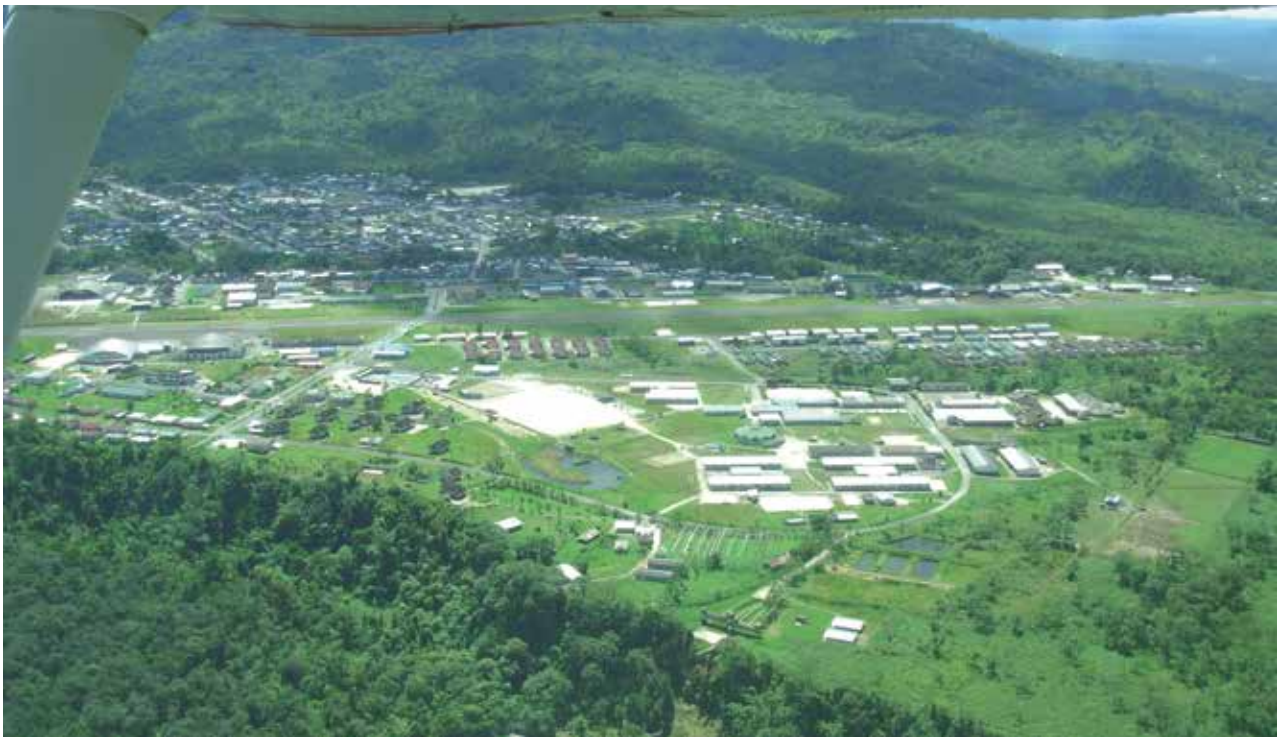
Instalación petrolera en la zona de Mera.
