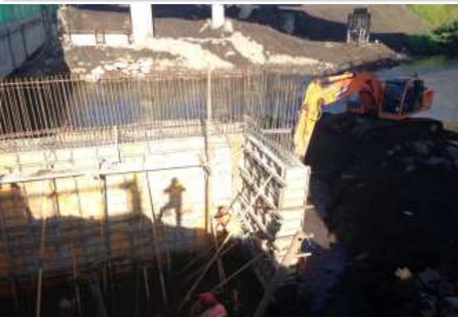
HORMIGÓN EN ESTRIBO DERECHO E IZQUIERDO - PUENTE 18
