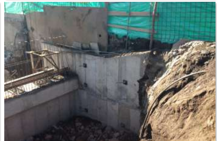
HORMIGÓN EN ESTRIBO DERECHO E IZQUIERDO - PUENTE 18
