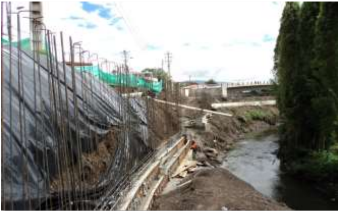
CONSTRUCCIÓN DE MURO ANCLADO RAMPA 5
