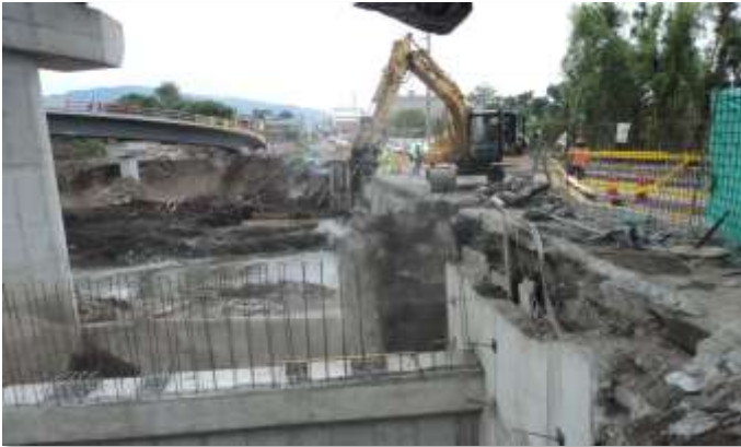
DERROCAMIENTO DE HORMIGÓN - PUENTE EXISTENTE EN LA AV. ILALÓ
