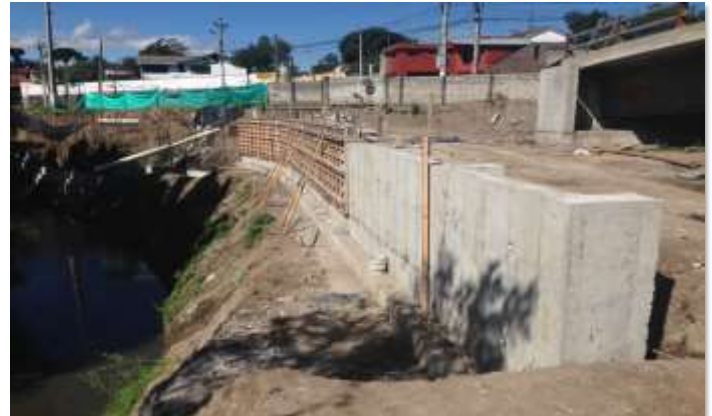
CONSTRUCCIÓN DE MURO ANCLADO RAMPA 5
