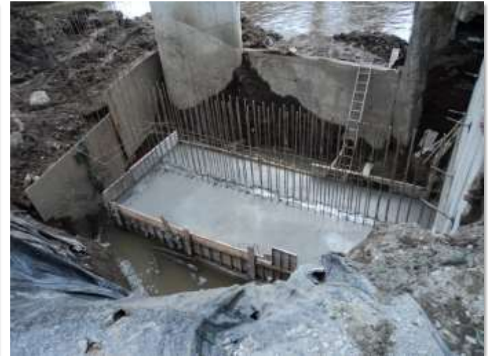
CONSTRUCCIÓN DE MURO ANCLADO RAMPA 5
