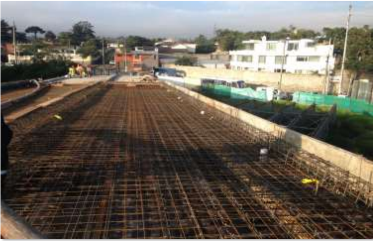
ACERO DE REFUERZO - PUENTE 17
